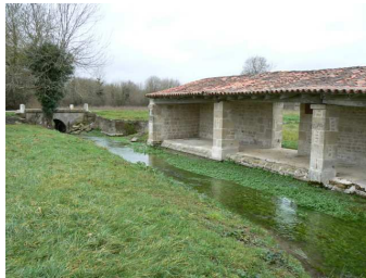
Le lavoir "du pont"
