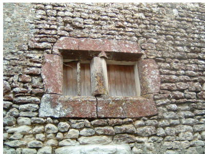
Maison à fenêtre « renaissance »
